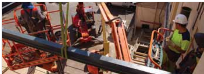
Les travaux en cours. Pose de poutrelles pour l'installation de coursives. (Photo E. Touvet)
